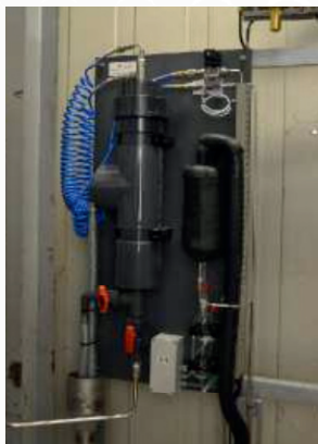
化工廠監測冷卻水內 是否有含氯有機物洩漏
